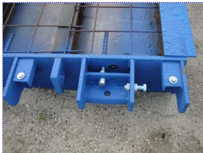
▲ Aanlevering en montage van weegbrug frame op de bouwplaats
