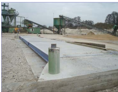
▶ Weegbrug gereed voor kalibratie en afwerking van aanvullende bouwkundige voorzieningen
