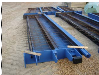
▲ Aanlevering en montage van weegbrug frame op de bouwplaats
