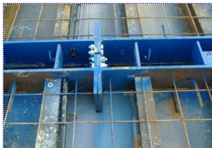
▲ Koppelen van de weegbrug frames en afwerken van de wapening
