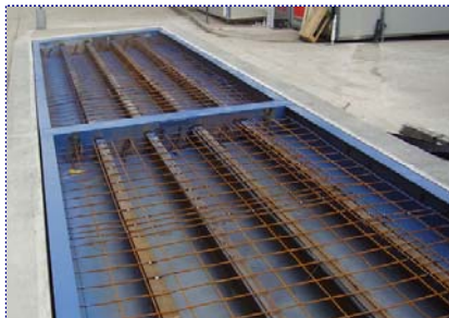
▲ Koppelen van de weegbrug frames en afwerken van de wapening
