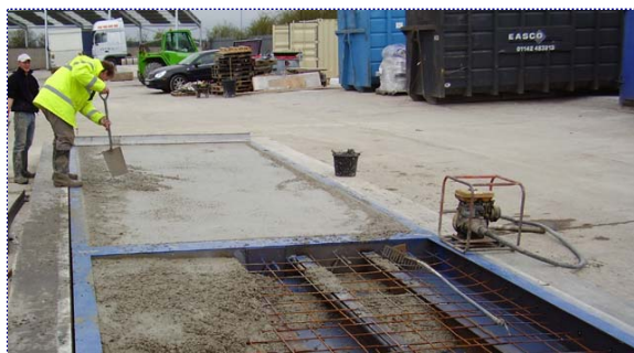
▲ Koppelen van de weegbrug frames en afwerken van de wapening
